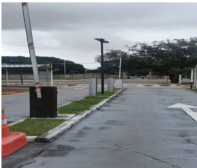
CANCELAS – ENTRADA DE VEÍCULOS
